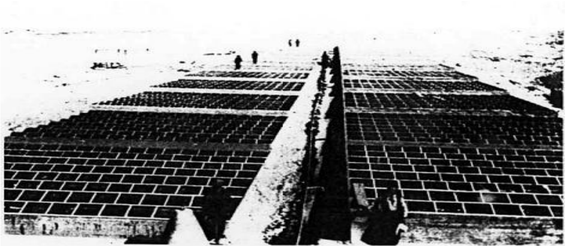
Figura 1.5.- Central de destilación solar en el desierto de Atacama, con una superficie de captación superior a los 4000 m 2 . Se trata de la primera central conocida de estas características en el mundo.
