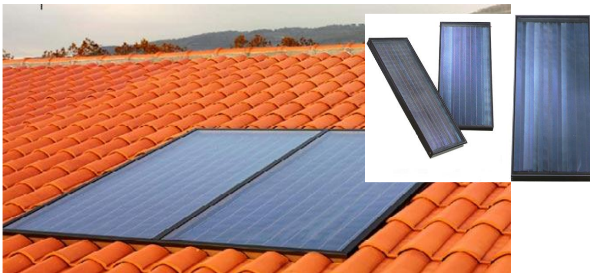
Figura 1.10.- Colectores solares planos.
