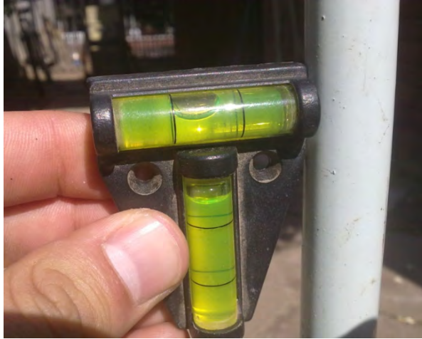
Figura 38: verificación de verticalidad.
