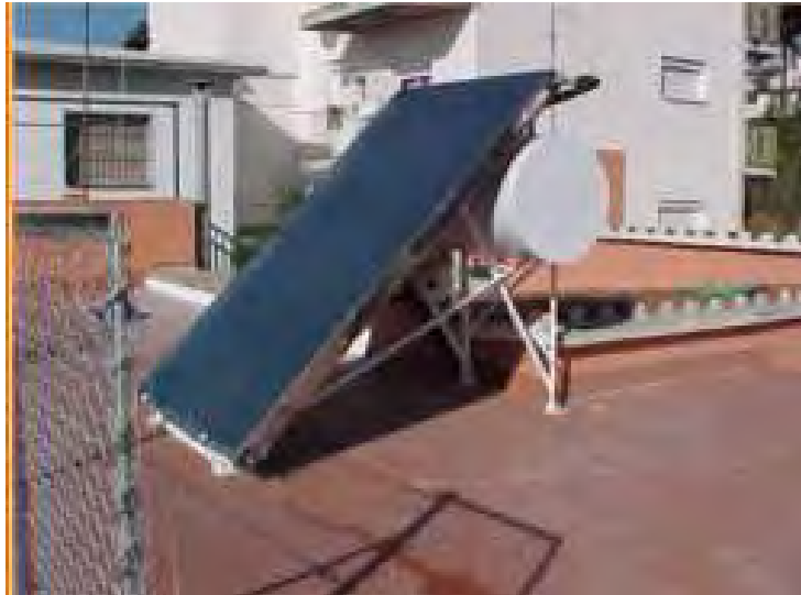
Figura 5: colectores solares planos de agua, los principales componentes de estos sistemas son la cubierta, placa absorbente, tubos por donde circula el fluido de trabajo, un aislante térmico y soporte. Es una tecnología de mantención e instalación sencilla [4].
