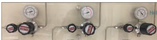
Figura A.6: De izquierda a derecha: Válvulas de nitrógeno, oxígeno y aire comprimido .
