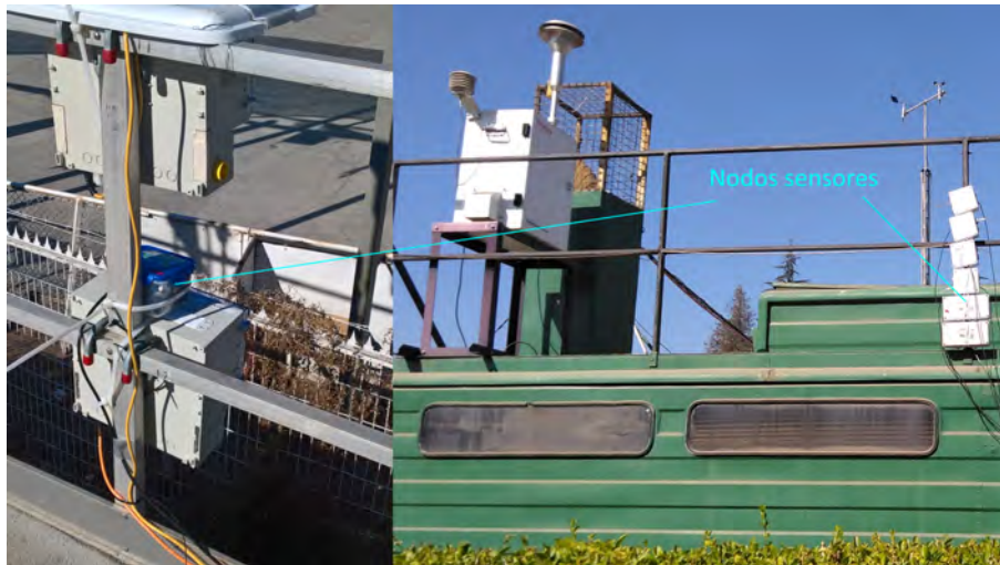
Figura 18: Instalación de nodos sensores en estación de referencia. Izquierda: La Florida (julio de 2019). Derecha: Las Condes (marzo de 2020)
