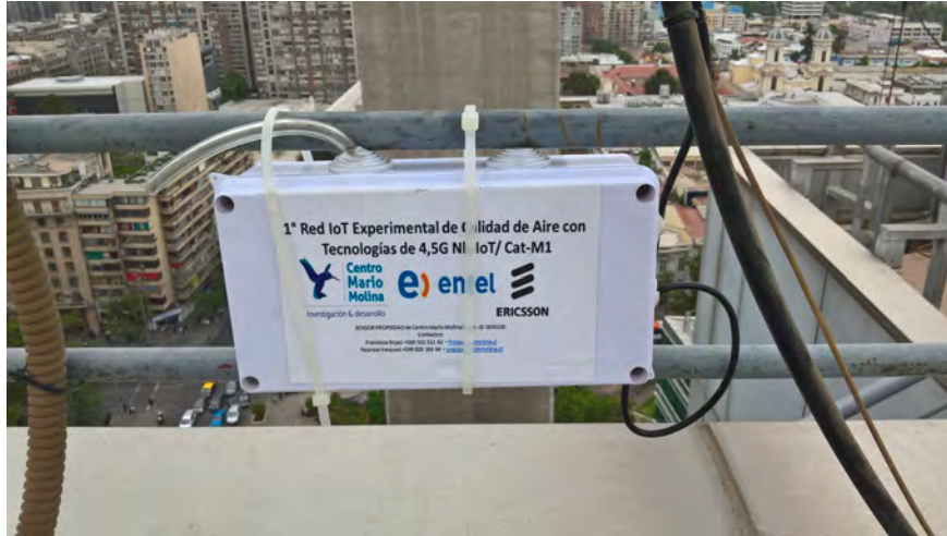
Figura 41: Nodo sensor instalado en helipuerto de la Torre Entel
