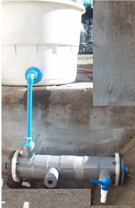
Figura 6.6 Fotografía del reactor ultravioleta Karalakis 1.0 operando, conectado a estanque en altura.
